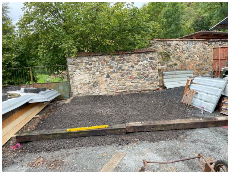
Obrázek 15: Urovnaná rozměřená plocha.
