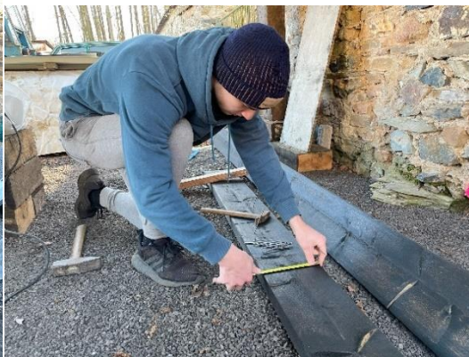
Obrázek 24: Vyměřování míst na hřebíky.
