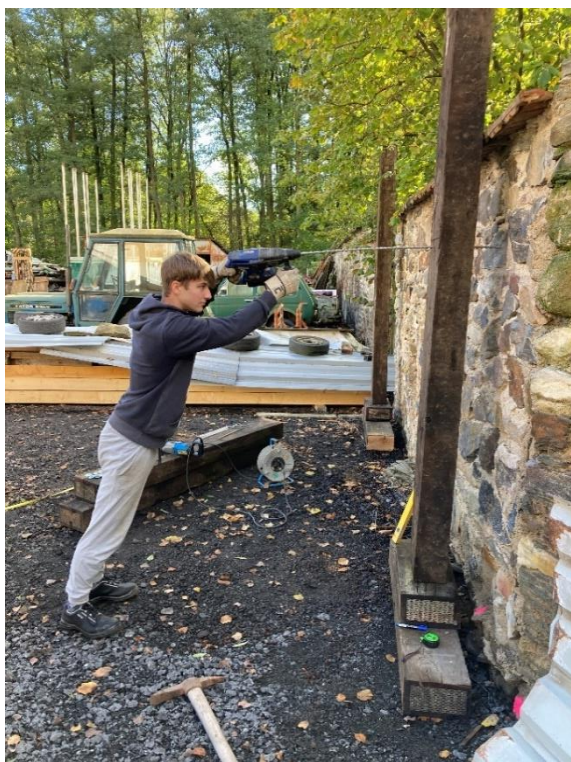
Obrázek 16: Vrtání otvoru na závitovou tyč do zdi.
