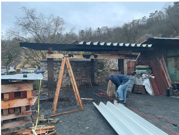
Obrázek 20: Vrtání děr na upevnění plechu.
