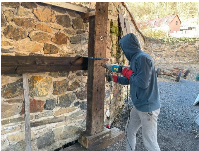
Obrázek 23: Upevňování věšáku na kleště.
