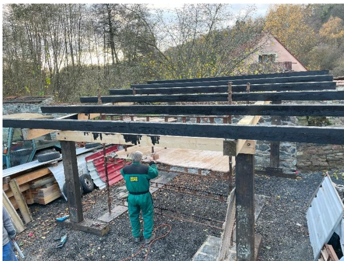
Obrázek 19: Konstrukce je připravena na zastřešení.
