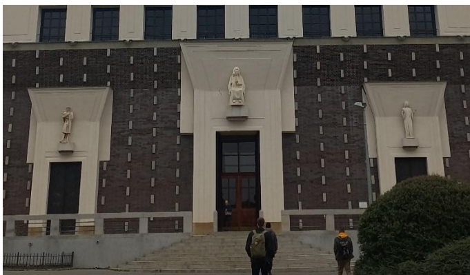
Obrázek 16: Přední stěna s portály
