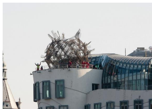
Obrázek 4: Kopule a terasa na střeše
