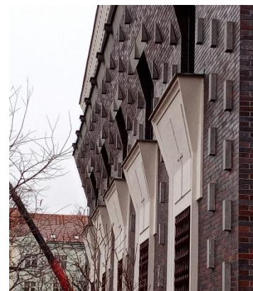
Obrázek 15: Zadní stěna kostela. Viditelné vystouplé prvky na fasádě
