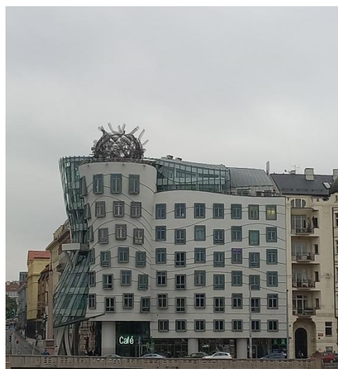
Obrázek 17: Pohled na západní stěnu z Jiráskova mostu
